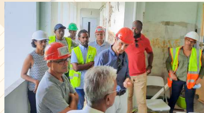
Visite de chantier du président de l'université des Antilles durant la phase de désamiantage
