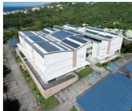
Rénovation énergétique bâtiment S
