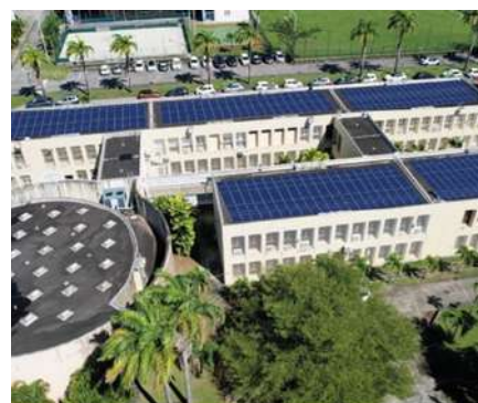
Rénovation énergétique bâtiment principal UFR DE (en cours)
