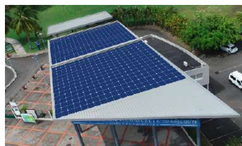
Rénovation énergétique du Bâtiment Accueil du Pôle Guadeloupe
