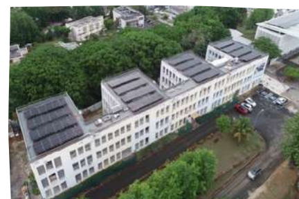
Rénovation énergétique du bâtiment enseignement de l'UFR SEN
