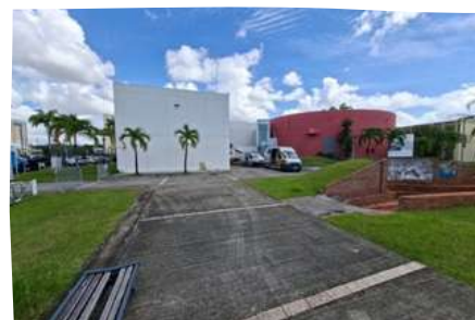
Accès handicapé UFR STE avant-après
