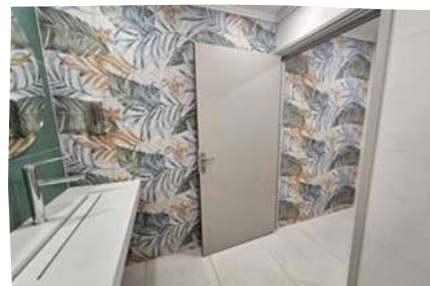
Rénovation des sanitaires et sol du 3 ème étage de l'administration générale
