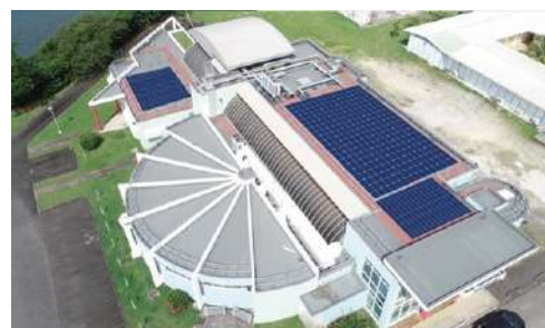
Rénovation énergétique de l'UFR Santé.
