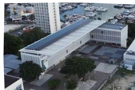
Installation PV et travaux connexe sur le bâtiment TP-DOSIP, avant-après
