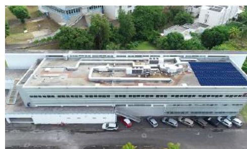
Rénovation énergétique de la BU du campus de Fouillole.
