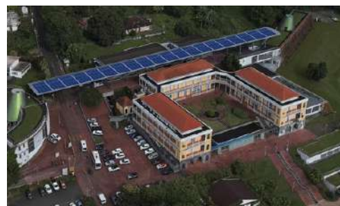
Rénovation énergétique du Campus du Camp Jacob
