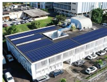
PUR 972 Rénovation énergétique
